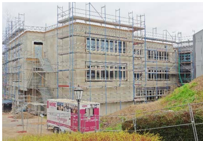
Der dreistöckige Schulbau macht sehr gute Fortschritte.
