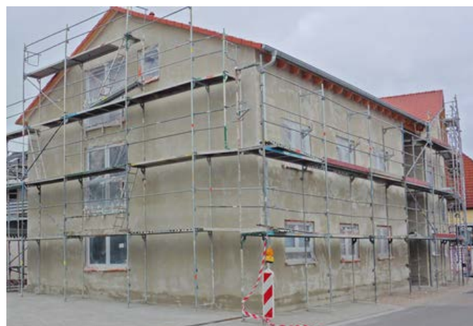
An der Außenfassade des Mehrfamilienhauses in der Wilhelmstraße 13 wurde gerade der abschließende Verputzaufgetragen.
