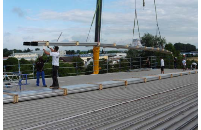
35 Meter lang sind die verarbeiteten Aluminium-Profibleche.
