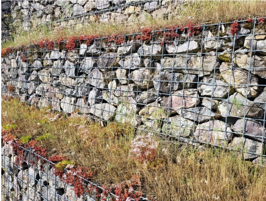
Abb. 7 Gabionen mit bewachsenem Absatz/Oberfläche (trockenwarme Vegetation)
