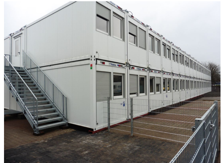
Noch vor dem Jahreswechsel wurde der aus zwei Containerriegeln bestehende Wohnkomplex bezugsfertig an den Rhein-Neckar-Kreis als künftigen Nutzer übergeben.
