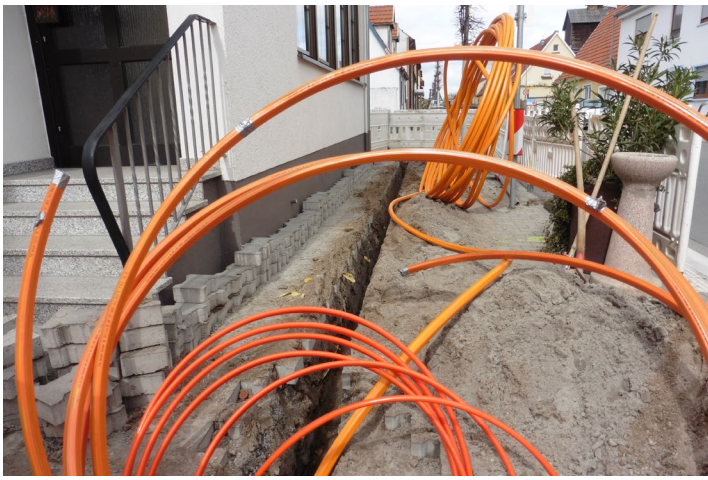
Der Aufbau einer innerörtlichen Glasfaserstruktur konnte 2022 vollendet werden. Die Netz-Aktivierung soll sukzessive im Verlauf des Frühjahrs erfolgen.
